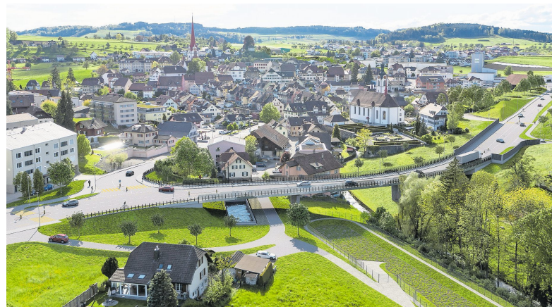
Eine Brücke über die Wyna soll als Teil der Umfahrung den Beromünsterer Flecken entlasten.
